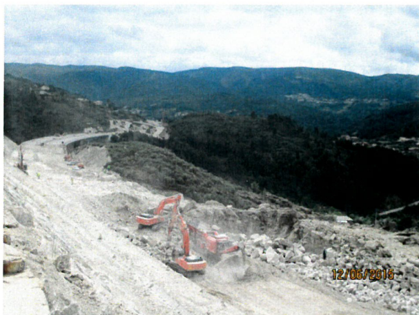
Foto 1 - Escavação e britagem de material
