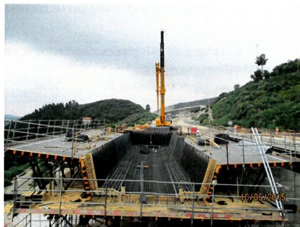
Foto 14 - Armação de Ferro do Viaduto 3
