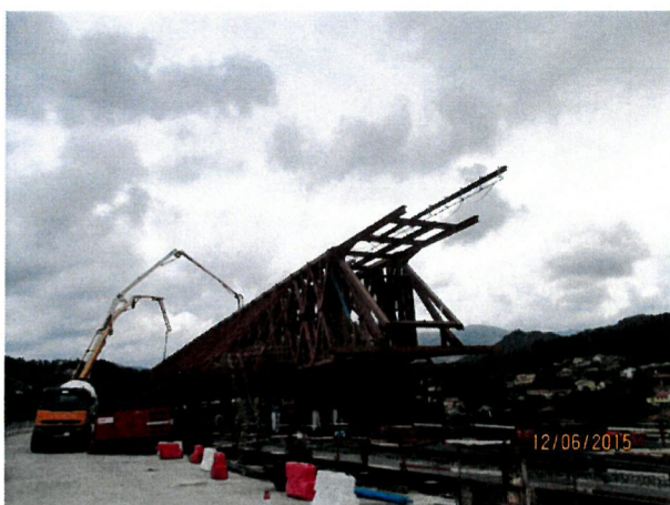
Foto 12 - Betonagem do Tabuleiro Direito Viaduto 1
