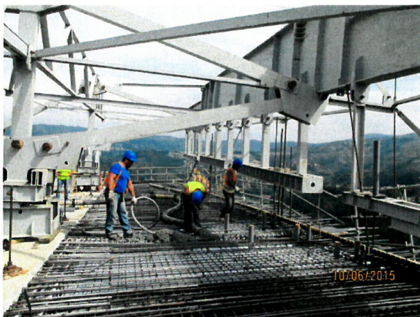
Foto 13 - Betonagem do Viaduto 3
