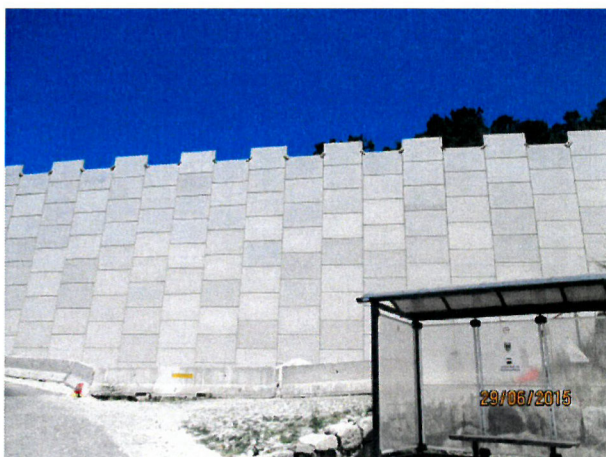
Foto 6 - Muro Terra Armada M20
