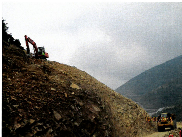
Foto 4 - Execução de valetas de crista
