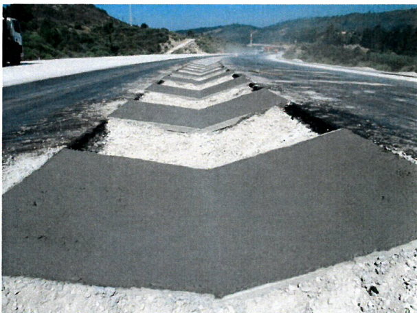
Foto 3 - Valeta Separador Central
